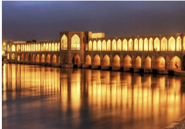
شکل ۲. پل خواجو، نظام آب با نظام منظر و آوا برگرفته از: (شهرداری اصفهان)
