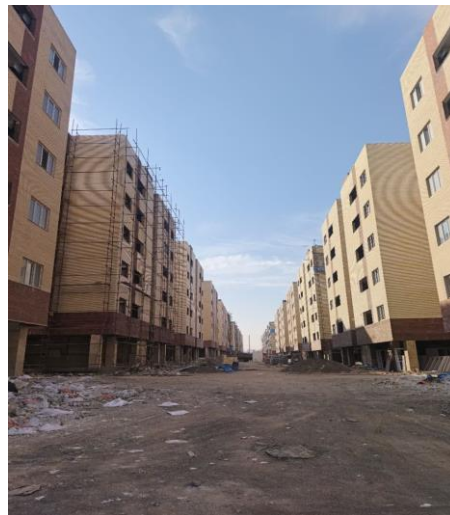
شکل ۲. مواردی از پروژه های مسکن در شهر قم (پردیسان)
